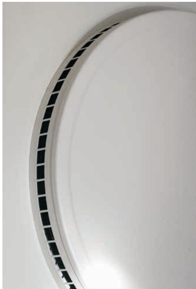
Ventilationssystemet ska kunna föra bort hälsofarliga ämnen, fukt, besvärande lukt mm.
